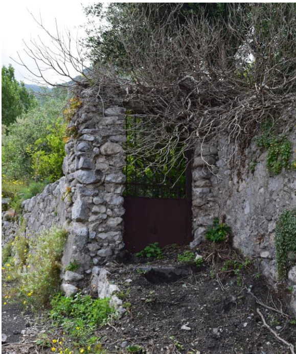
Figura 39: Terrazzamento con ingresso al fondo rustico integrato a Sant'Egidio del Monte Albino.
